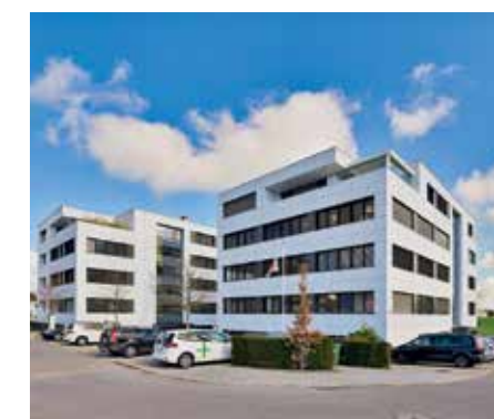
Naheliegender: Seit Anfang Jahr arbeiten wir im neuen Domizil am Buzibachring in Rothenburg
